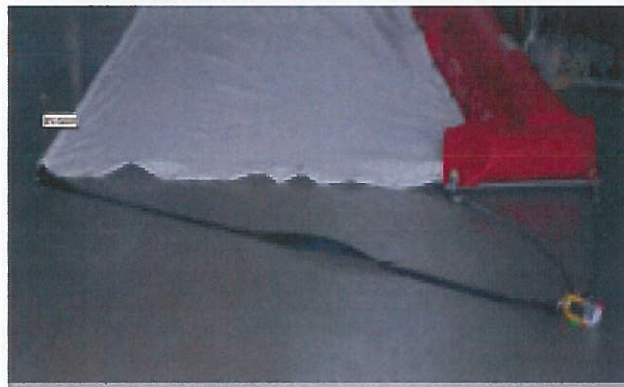
la ligne rouge de flotteurs soutient la nappe géotextile lestée par une chaîne cousue dans la bordure inférieure.
